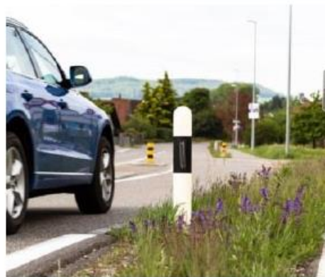
Abbildung 2: Zählgerät als Leitpfosten
